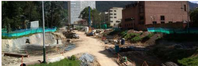
Construcción fase 3 Transmilenio, Colombia
